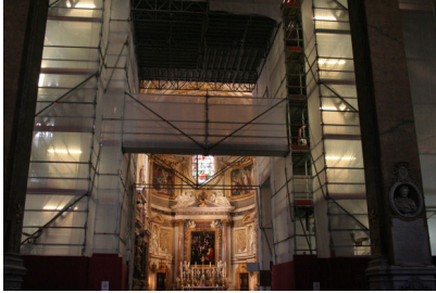
Römische Kirche in Umbau – Foto: Plum
