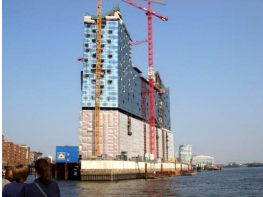
Elbphilharmonie Hamburg im Bau
